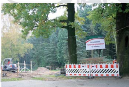
■ Beginn der Bauarbeiten
